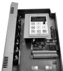
步驟2：完成拆卸面板工作
